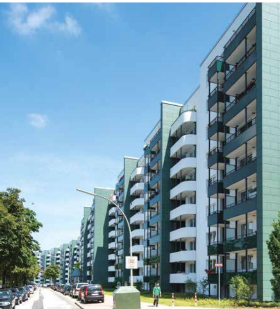
Die umfassende energetische Modernisierung, neue Farben und neue Loggien sind in der Straße Mümmelmannsberg weithin sichtbar
