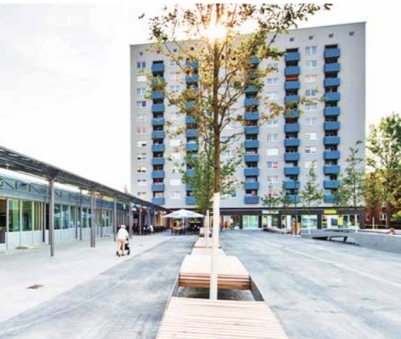
2013 wurde die umfangreiche Modernisierung der SAGA GWG Bestände rund um den Berta-Kröger-Platz in Wilhelmsburg abgeschlossen
