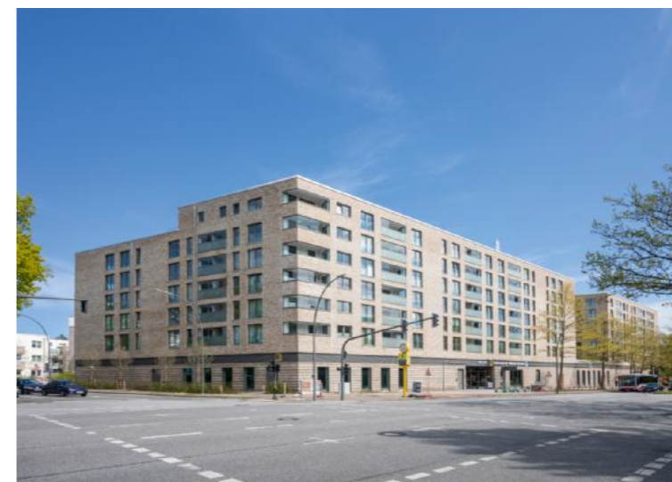
↙ Der Neubau an der Sengemannstraße
